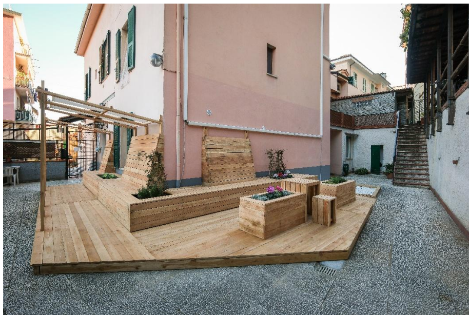
Fig.4 – La struttura esterna al termine dei lavori.
