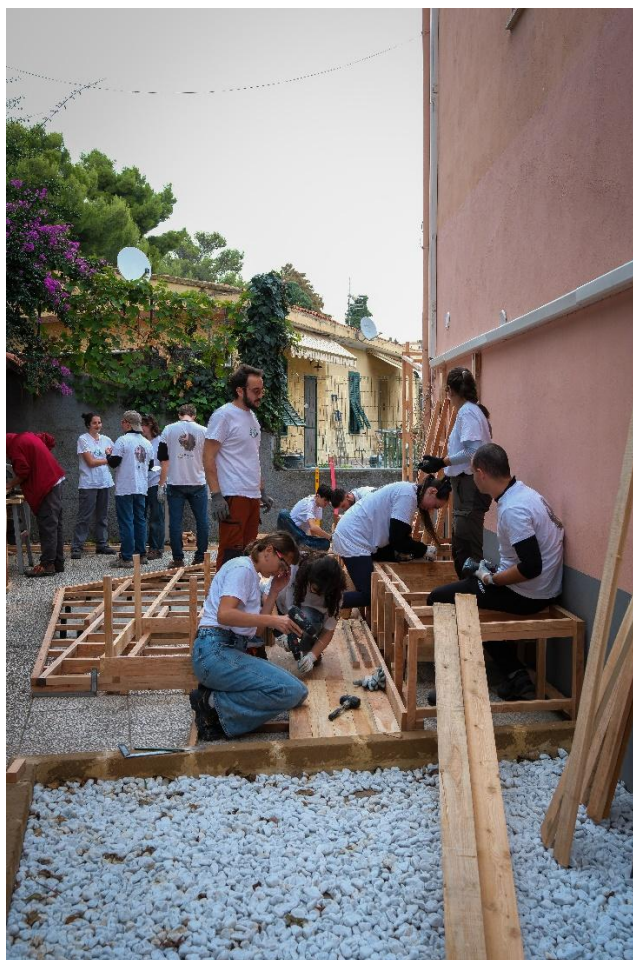
Fig.9 – Costruzione della pedana esterna con le sedute integrate.
